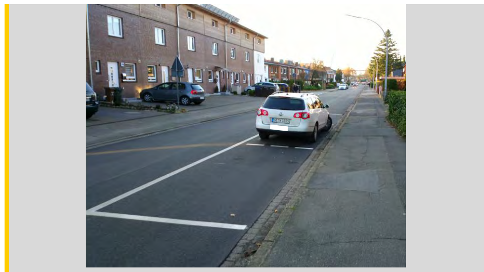
Abbildung 11: Parkflächenorganisation an der Beckersbergstraße
